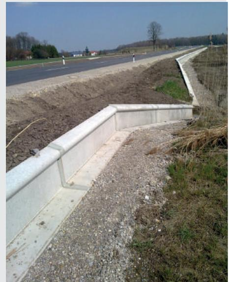
Durch das L-Element werden bis zu 50% weniger Erd- und Gründungsarbeiten er-forderlich. Durch Konstruktion und Betongüte verzichtet unser L-System auf Stahlar-mierung, dadurch wesentlich einfachere Anpassungsarbeiten vor Ort beim Schneiden, kein Korrosionsproblem. Unsere dauerelastische Fugenabdichtung garantiert eine ab-solut fugenfreie Leiteinrichtung auch bei leichter horizontaler und vertikaler Bewegung in der Fuge.
